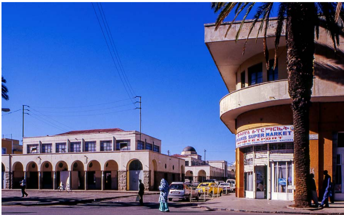
Fig. 2 © 2013, Maristella Casciato. Edificio per appartamenti e negozi (arch. Antonio Vitaliti, 1944 ca.) su Harnet Avenue all'angolo con la piazza del mercato. La lunga piazza, perimetrata da edifici su due piani porticati, fu realizzata su disegno di Guido Ferrazza, con Ferruccio Mazzanti e Giuseppe Arata, fra il 1938 e i primi anni Quaranta
