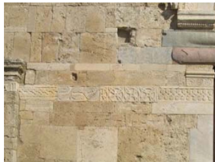
Fig. 4 © 2013, Cristiano Mengarelli. Cattedrale di S. Maria, facciata, elementi scultorei riutilizzati, lato sinistro.
